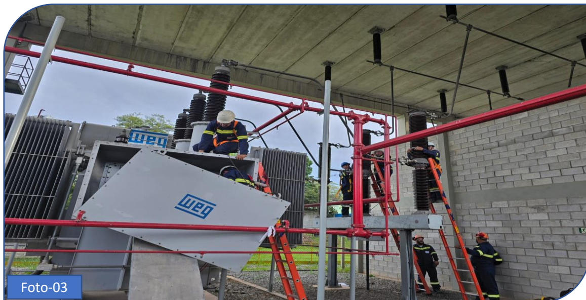
Foto-03: Abertura das tampas dos equipamentos para inspeção, limpeza, reaperto das conexões eletromecânicas e ensaios elétricos.
