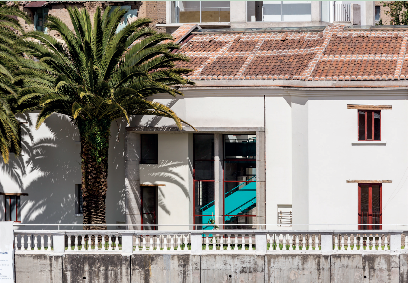
Vestíbulo bloco A
