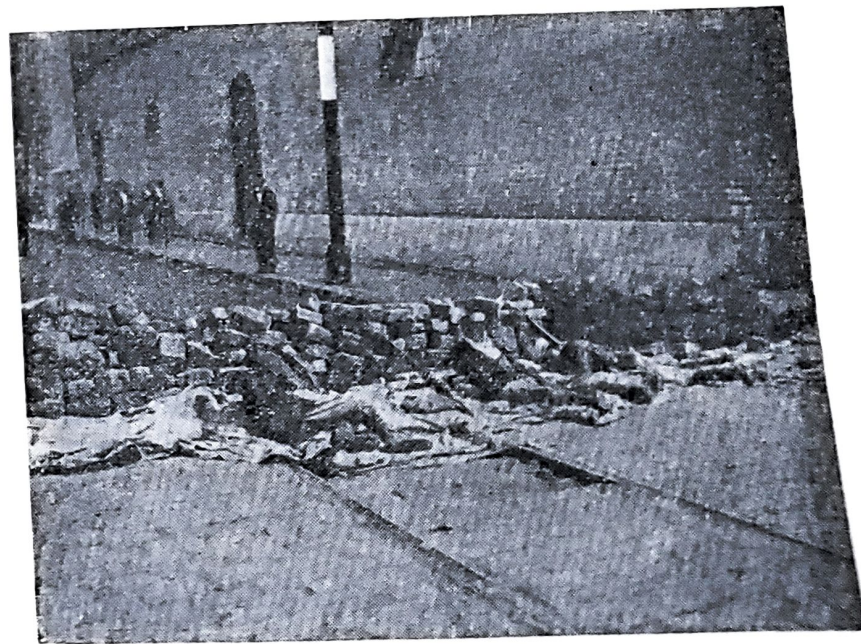
Trincheira revoltosa ao lado da Estação da Sorocabana.
